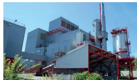
Le CVE de Douchy-les-Mines chauffe environ 1 500 logements
